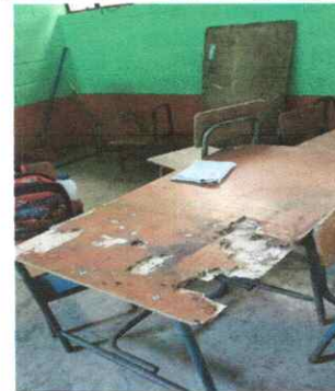
Foto 4: Puertas y mobiliario en mal estado
